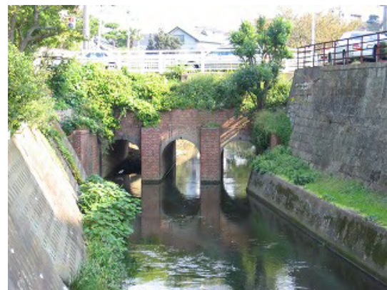
小山樋門橋(レンガ橋)
