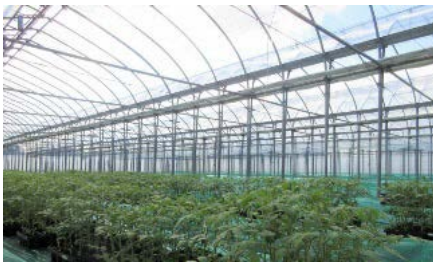
【パイプハウス】
