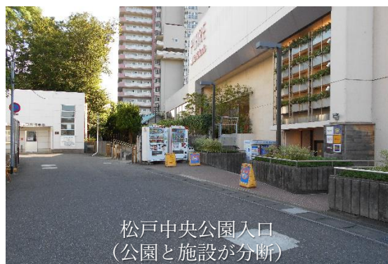
松戸中央公園入口 (公園と施設が分断) 図 2-2-3 新拠点ゾーンの課題①
