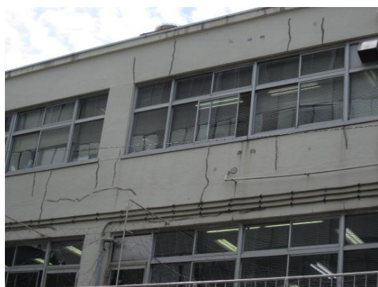
図6-2-4 本館外壁の状況
