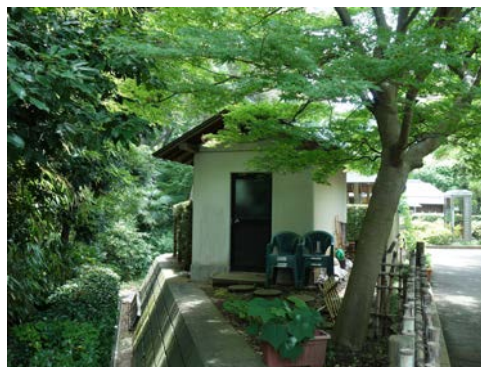
⑬放水銃用のポンプ小屋（今後は易操作性消火栓用として使用予定）
