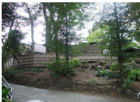
⑨土留め石〔表門西側、離座敷棟北側など〕 ※写真は表門西側の土留め石
