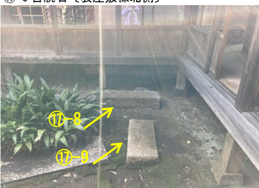
⑩-8、⑩-9 沓脱石〔奥座敷棟東側〕
