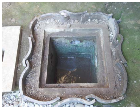
雨水浸透柵の内部
