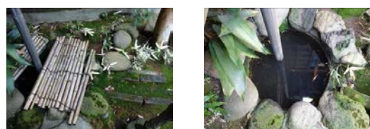
⑭-5 雨水排水設備（溜め壺型）〔表座敷棟北側〕
