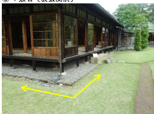
⑧雨落ち溝〔表座敷棟南・西側〕
