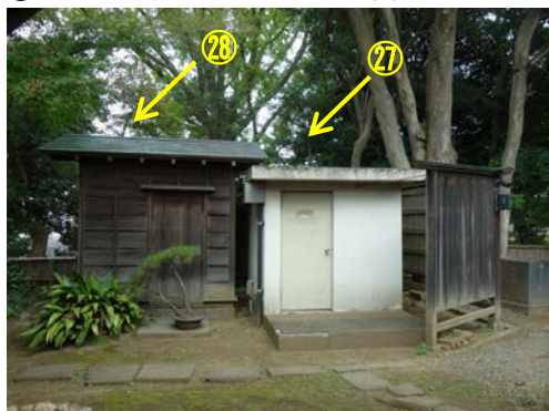
②⑦屋外消火栓用のポンプ小屋(今後は使用しない) ②⑧水圧小屋(現在使用していない)
