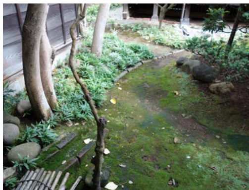
②③煉瓦と土管の排水溝〔表座敷棟北側〕
