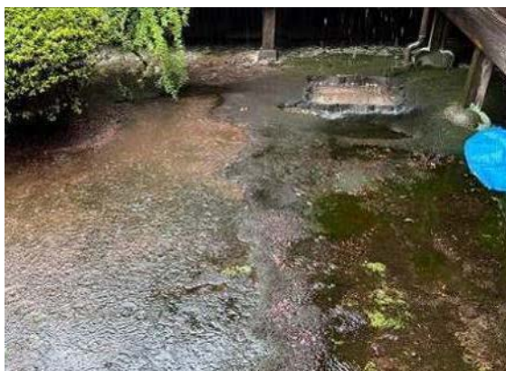
降雨時の中庭（玄関棟）の排水状況（右上が雨水浸透柵）
