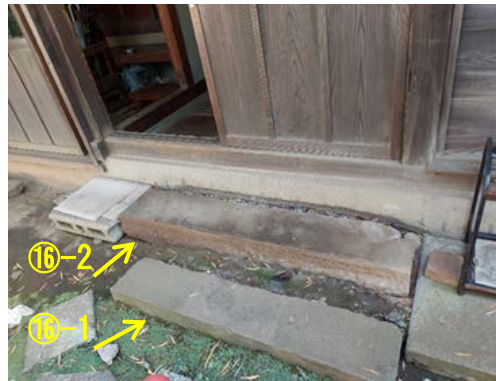
⑩-1~2 敷石〔台所棟北側〕2か所
