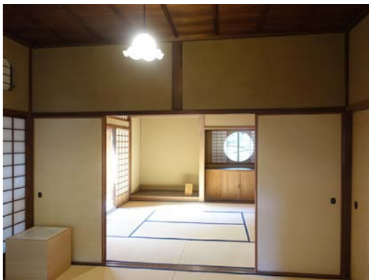
次の間から座敷を見る
