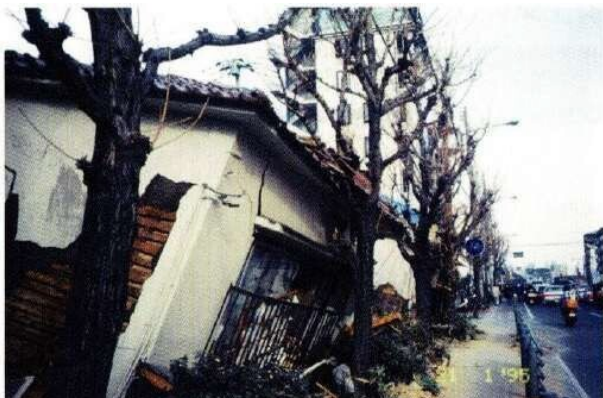
阪神淡路大震災で建物倒壊を防ぎ 道路への被害を低減させたイチヨウの街路樹 (出典:街路樹せん定ハンドブック第5版)
