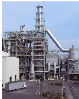
バイオマス発電所
