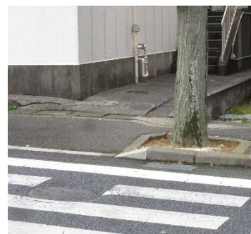
④の例(横断歩道内の街路樹)
