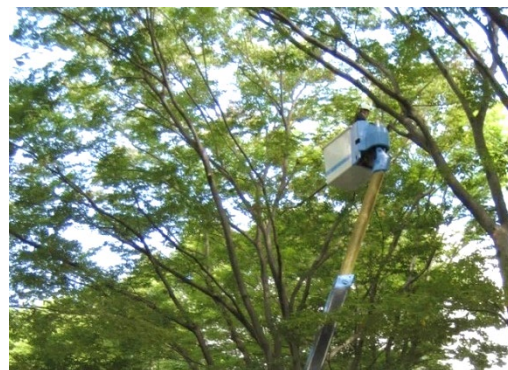
枯れ枝除去作業の状況。枝の間に作業床を伸ばし、車両の位置を変えながら、まんべんなく行うため、時間を要する作業である。
