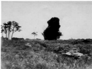
対戦車壕の爆破 工兵学校八柱作業場(清宮場) 撮影年月日不明(昭和12年以降撮影) 泰山青島氏寄贈
