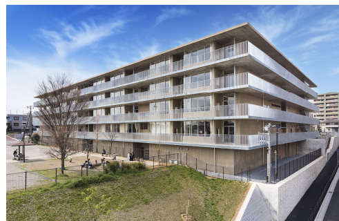
東松戸小学校新築工事
