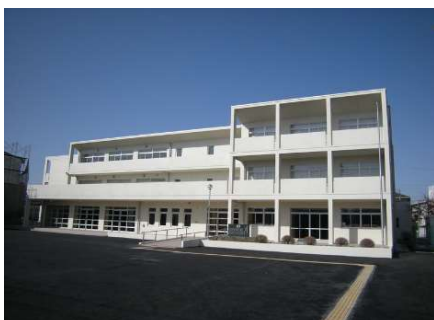
小金中学校改築工事
