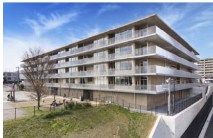
東松戸小学校新築工事
