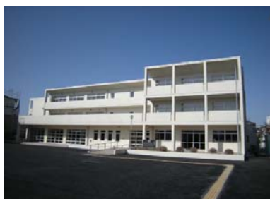
小金中学校改築工事
