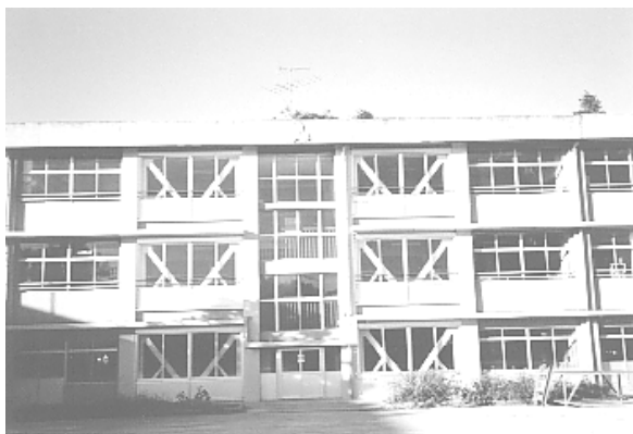
校舎耐震改修工事
