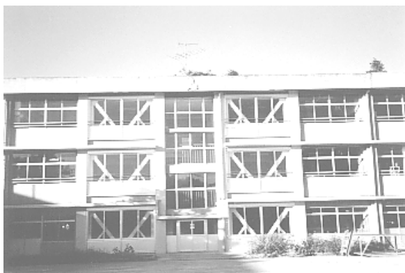
校舎耐震改修工事
