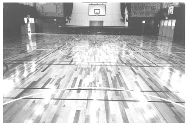
屋内体育館改修工事
