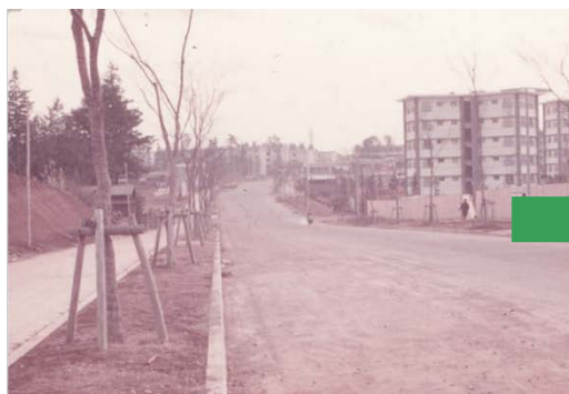
常盤平駅方面よりポイントハウスを見る
