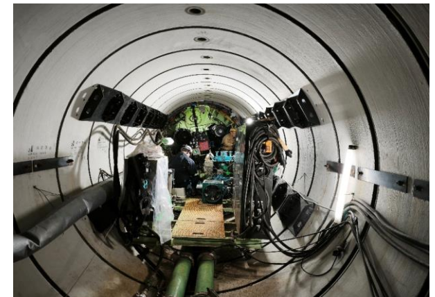
TNo. 2-2→TNo. 2-1 推進工（推進先頭付近）
