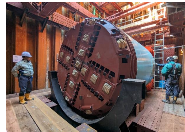
TNo. 2-3 掘進機設置完了状況
