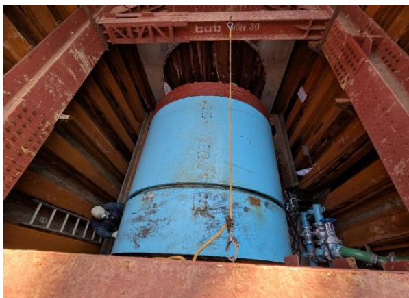
TNo. 2-3 掘進機設置完了状況
