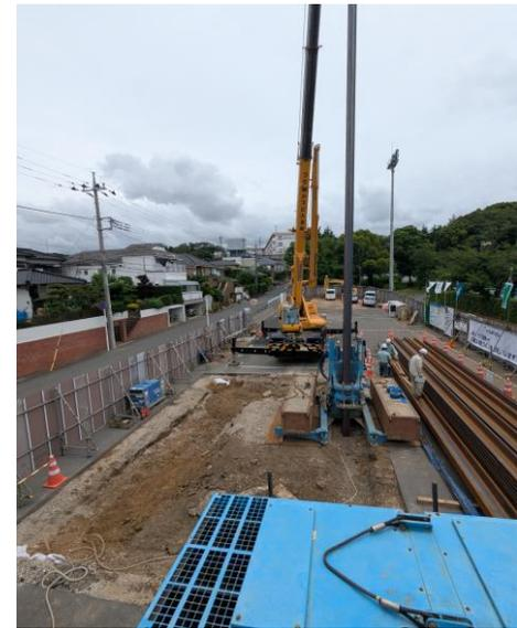
TNo.2-3 施工状況 (鋼矢板打設状況)
