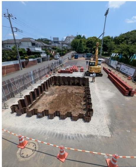
TNo.2-3 施工後 (鋼矢板打設)
