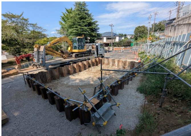
TNo. 2-2 掘削前 (立坑掘削)
