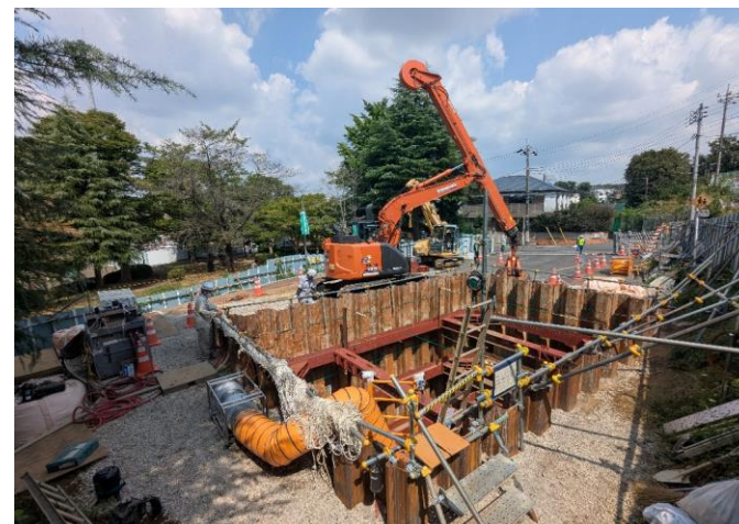
TNo. 2-2 掘削状況 (立坑掘削)
