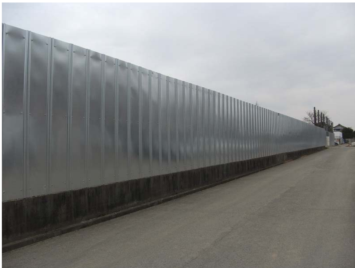
⑥【解体工事で設置したフェンス（施設計画区域 外周に設置）】※北側
