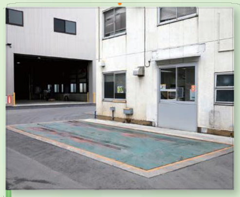
計量機 搬入物・搬出物の重さを計ります。
