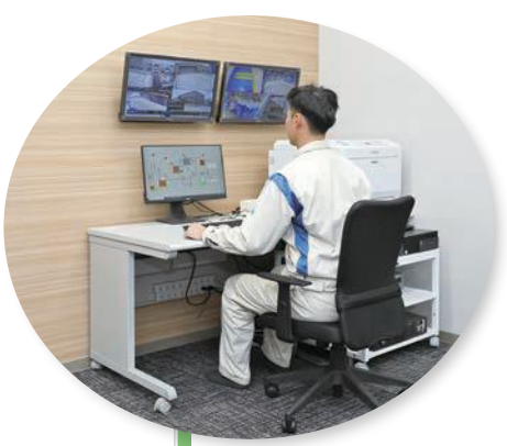
中央操作室 施設内の各機器を操作し、その状態を監視します。
