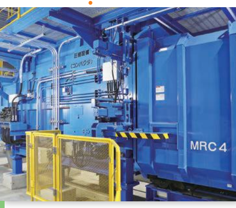
圧縮設備 (コンパクト) 燃やせるごみをコンテナに押し込みます。
