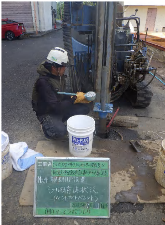
止水材（ベントナイトペレット） 充填状況
