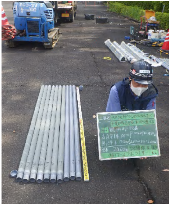
材料検収 井戸材 (VP50) 有孔管 2.00m × 7本 = 14.00m 無孔管 2.00m × 3本 = 6.00m 計 = 20.00m
