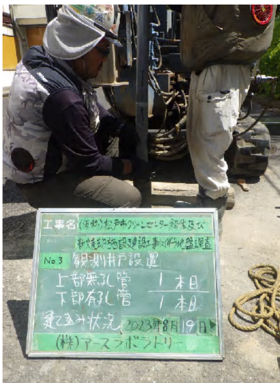
井戸管建込状況 有孔管1本目-無孔管1本目
