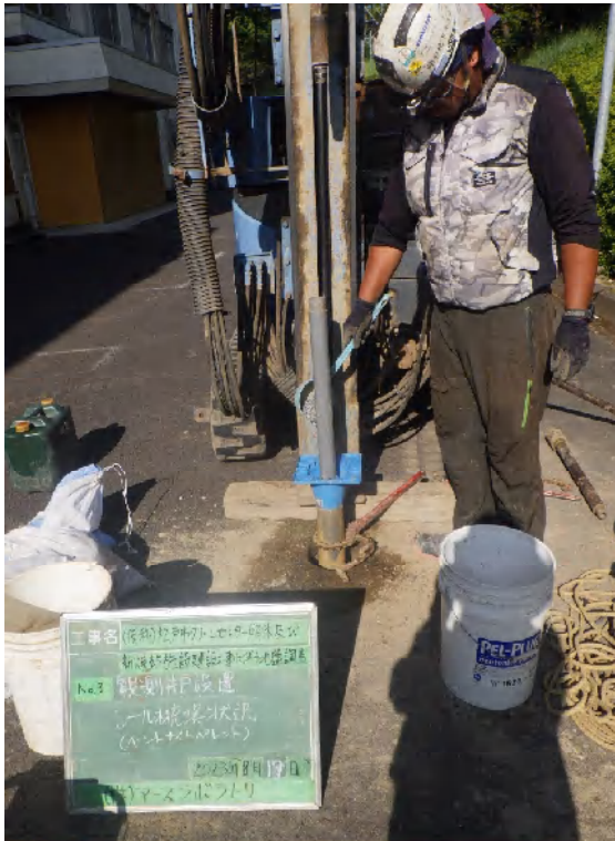
止水材（ペントナイトペレット） 充填状況
