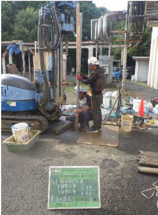
井戸管建込状況 有孔管1本目-無孔管3本目
