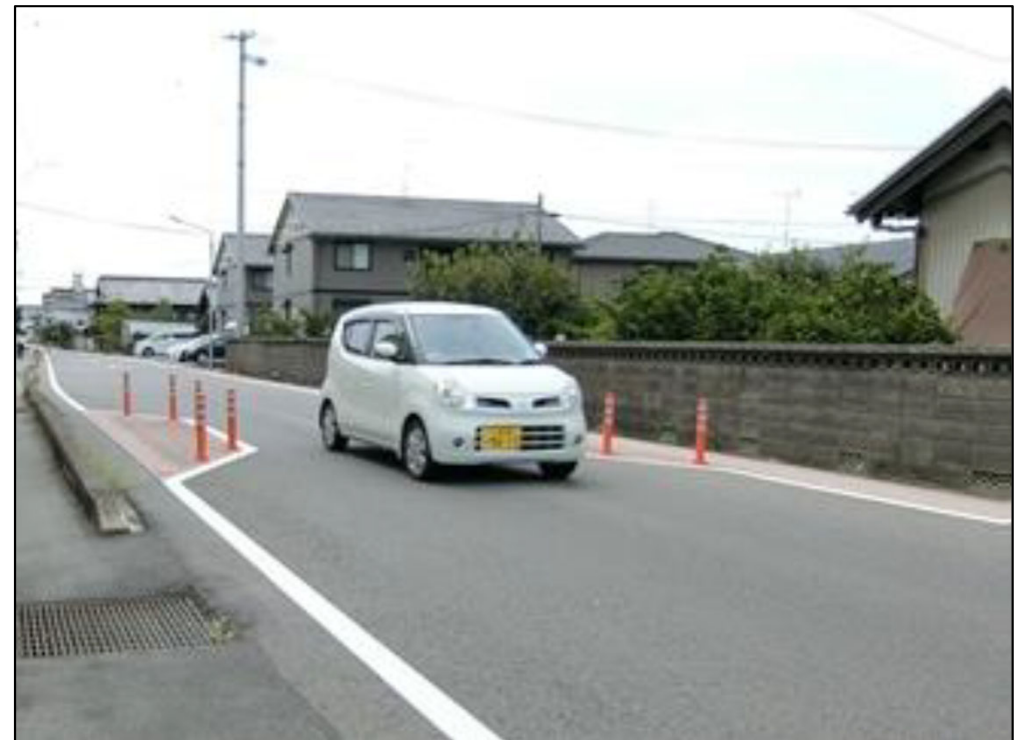
単路区間における両側張り出しによる狭窄の事例（稲沢市）
