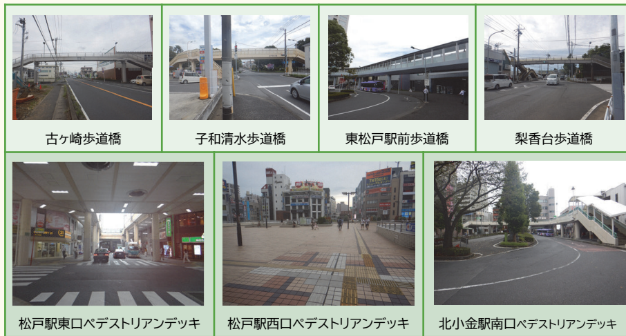
写真1 対象横断歩道橋の状況
