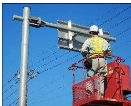
近接目視点検状況
