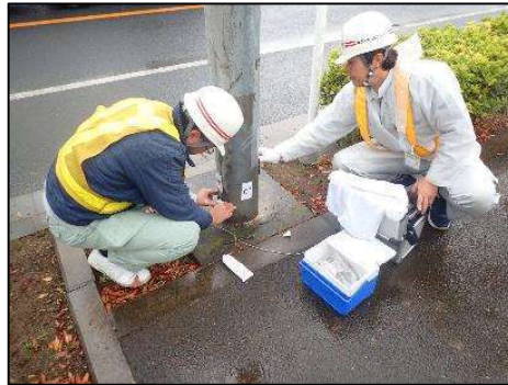
非破壊手法による腐食調査
