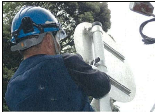
近接目視点検状況
