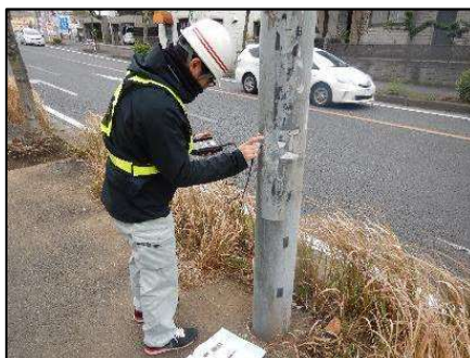
残存板厚調査
