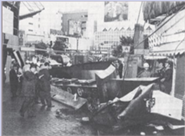
台風で落下した時の様子
