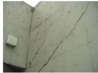
打放しコンクリートのひび割れ
