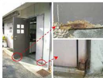
扉、扉枠の腐食
