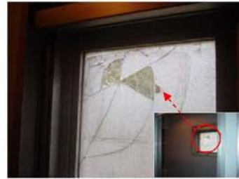
ガラスの割れ
