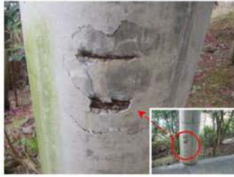
柱コンクリートのひび割れ、鉄筋露
