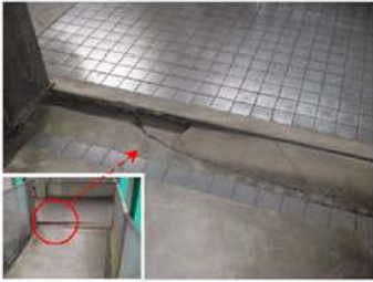
沈下による段差
