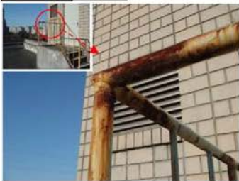
手摺りの腐食
