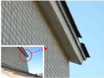
軒下瓦の脱落
