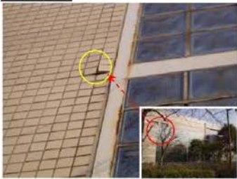
タイルの剥がれ
