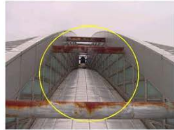
鉄骨梁の腐食
