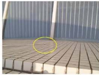
タイルの浮き
