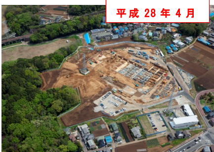
基礎の鉄筋・型枠工事
