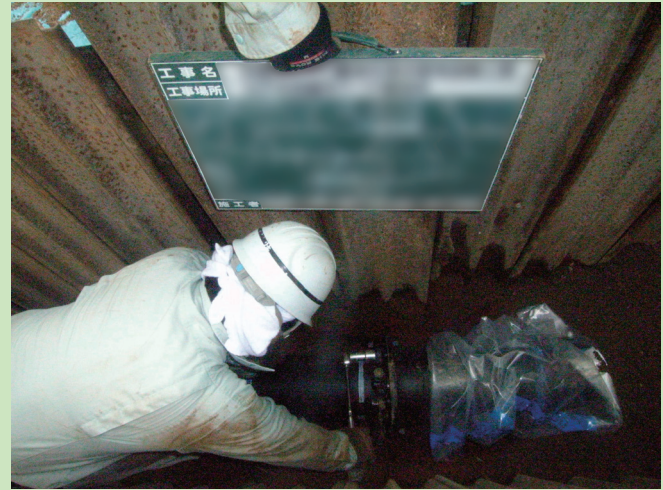
導・配水管の取替工事
