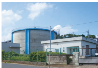
▲幸田配水場配水池
