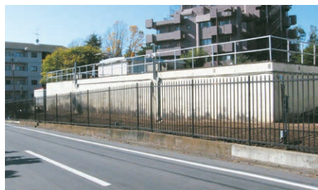
▲常盤平浄水場第3配水池
