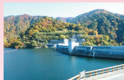
▲矢木沢ダムの写真 ▲出典:独立行政法人水資源機構 ホームページ内写真を加工して作成
