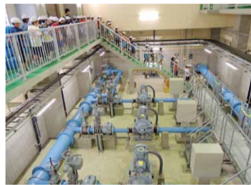
小金浄水場：配水ポンプ室
