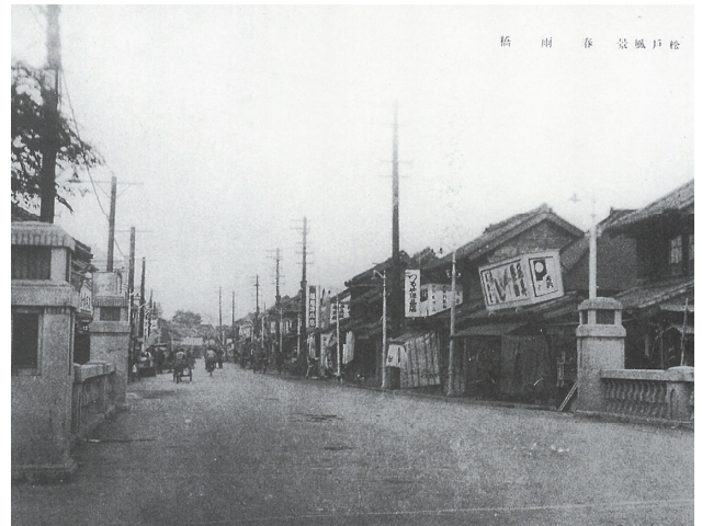
水戸街道春雨橋付近（昭和 10 年頃）
