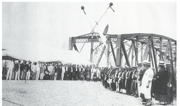
葛飾橋 (鉄橋) の開通式 (昭和 2 年)
