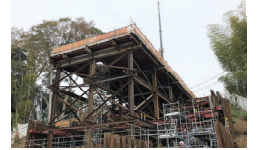
道路築造のための仮設構造物(区画整理担当室)
