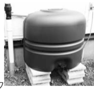
雨水貯留タンク
