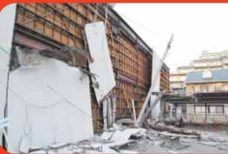
壁が崩落した遊技場
