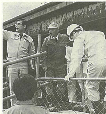
上富士川改修工事の現場で、職員に説明を求め
