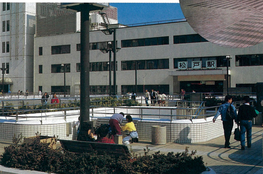
松戸駅西口地下駐車場が六十年十月に完成し、翌年から順次、駅西口高架遊歩道・駅東西自由通路・駅東口デッキが完成しました
