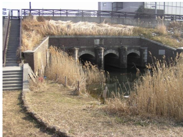
【柳原水閘】 1904年に作られたレンガ造りの水門で、土木遺産に認定されています。
