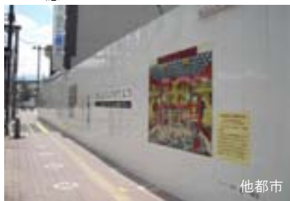
◎ 工事中の塀におけるまち並みへの配慮
