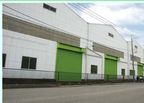
色彩の分節化により親しみやすい外観の倉庫
