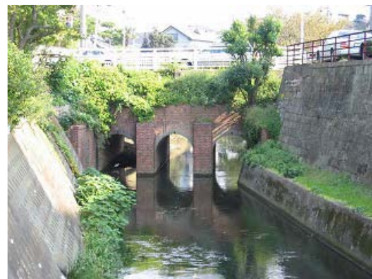
小山樋門橋(レンガ橋)
