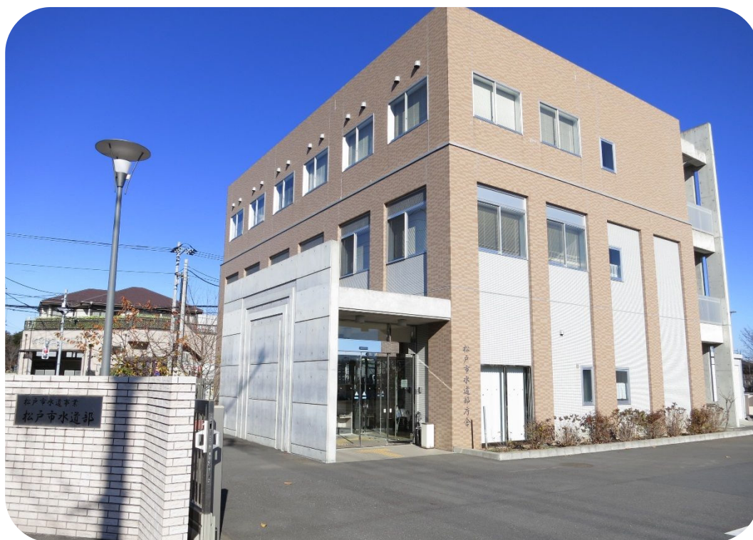
松戸市水道部小金庁舎
