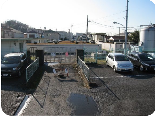
大金平浄水場正門前
