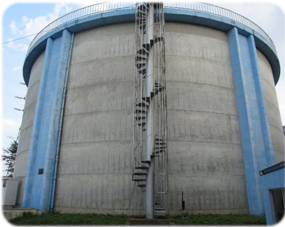
図 5-2.幸田配水場配水池
