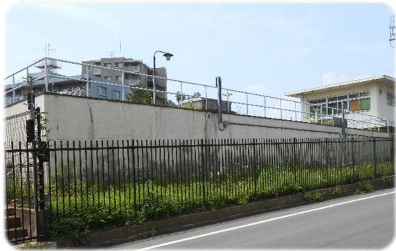
図 5-3.常盤平浄水場配水池
