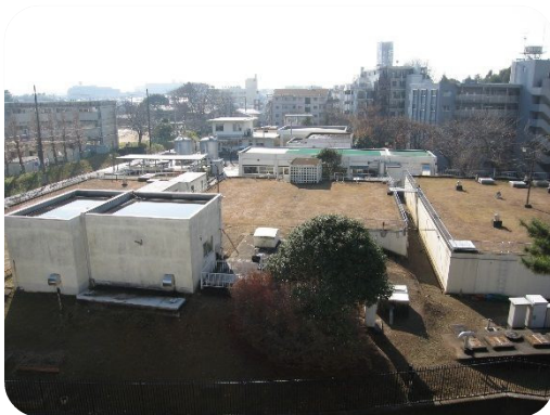
常盤平浄水場全景
