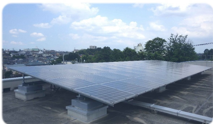
図 5-7. 太陽光パネル (小金浄水場屋上設置)
