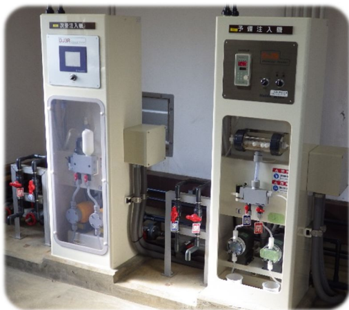
図 5-1.次亜塩素酸ナトリウム注入設備
