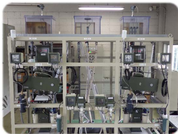
図 3-6.連続水質監視装置 (常盤平浄水場)
