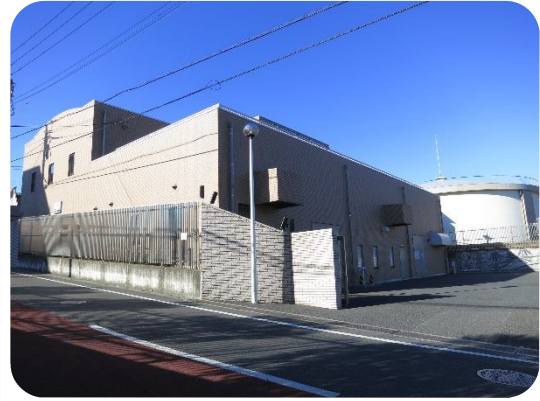
小金浄水場全景
