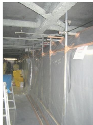
図 4.7.6 同上施工区画 (内部側、右外側が車路)
