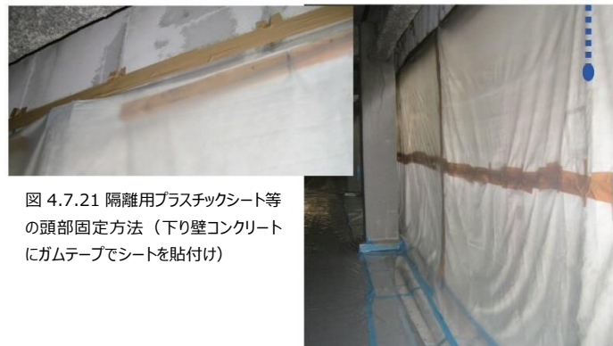
図 4.7.22 開口部の負圧隔離養生（防災シートの内側にプラスチックシート等で養生）
