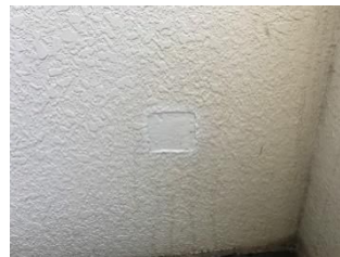
(固化および簡易補修後)
