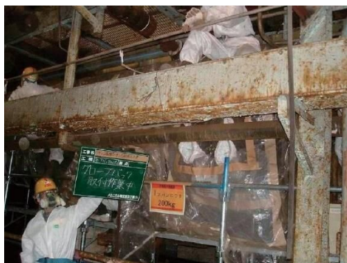
図 4.10.8 グローブバッグ取付作業中
