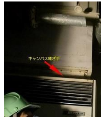
（参考資料）写真6-11 キャンバス継ぎ手
