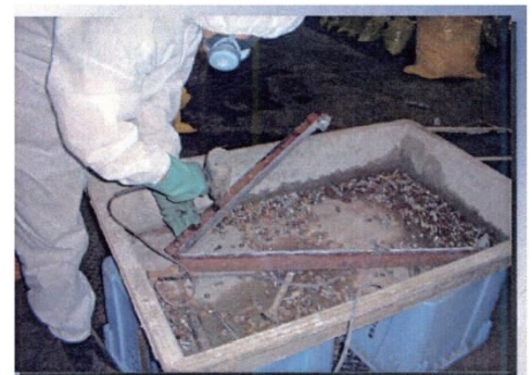
図4.11.17 掻き落とし除去作業の例
