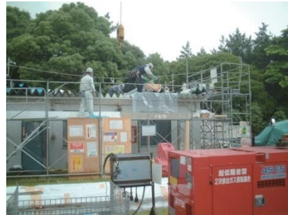
図 4.10.17 折板をはがしているところ
