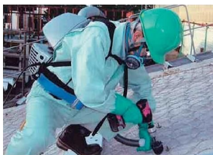
粉じん回収（高性能真空掃除機）
