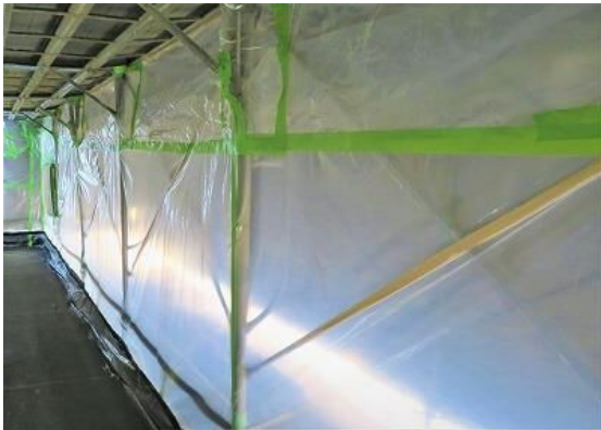
周囲への飛沫飛散防止養生例（内部）
