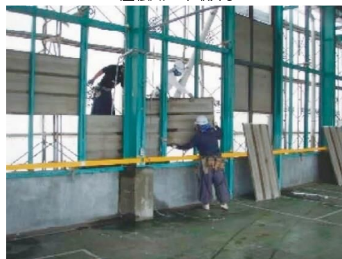
壁石綿含有成形板取外し
