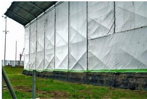
周囲への飛沫飛散防止養生例（外部）
