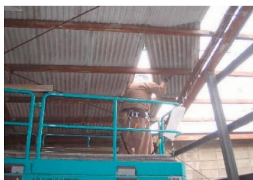
屋根スレート取外し
