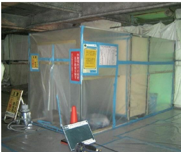
図 4.7.28 セキュリティゾーン外観
