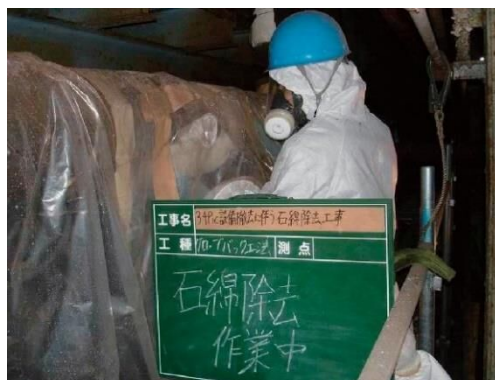
図 4.10.9 石綿除去作業中 1
