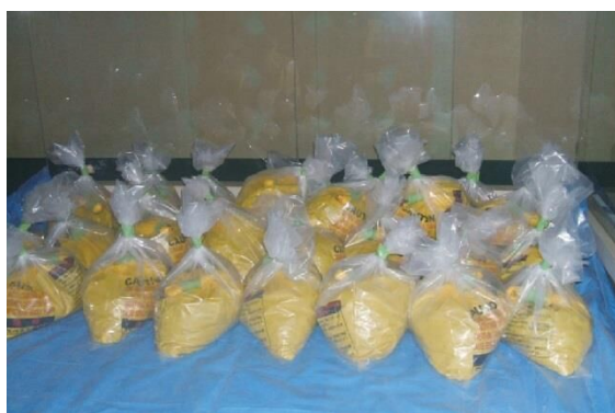
図 4.7.78 除去した石綿廃棄物の保管
