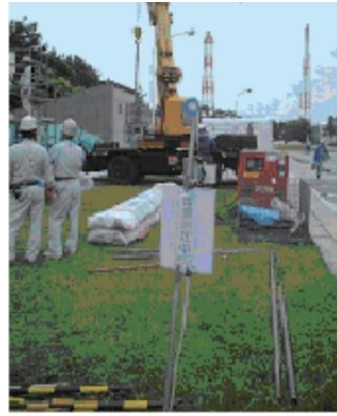
図 4.10.15 折板をプラスチックシートで梱包後、クレーンで吊り下ろしたところ
