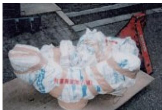
図 4.8.7 除去した石綿含有保温材付配管を梱包し、廃石綿等として処理した例 (廃棄にあたっては石綿を含む廃棄物が入っていること及び取扱い注意事項を表示する。)
