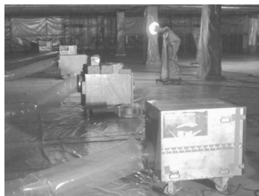
図 4.7.45 集じん・排気装置への排気ダクトの取付け
