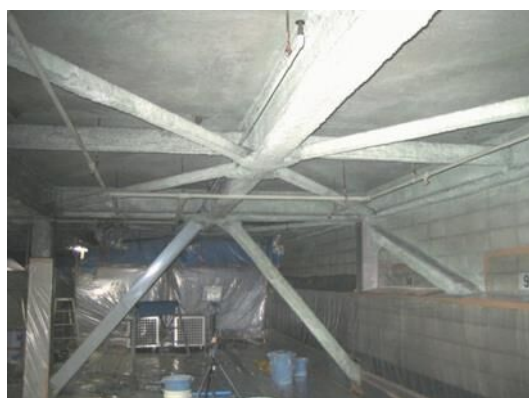
図 4.7.5 同上施工区画の内部側
