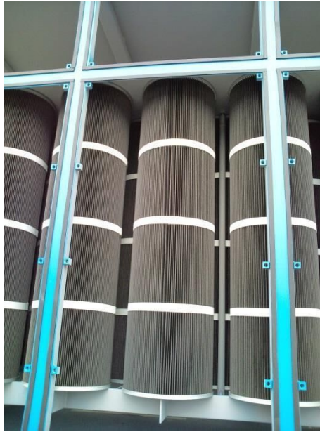
写真Ⅲ-2 プリーツ成形フィルタの例
