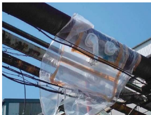
図 4.10.3 切断箇所へのグローブバッグ取付
