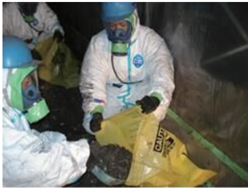
図 4.7.75 除去した石綿廃棄物の袋詰め (一重目)
