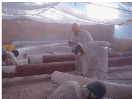
図 4.10.6 吊り下ろした配管内の保温材の除去作業
