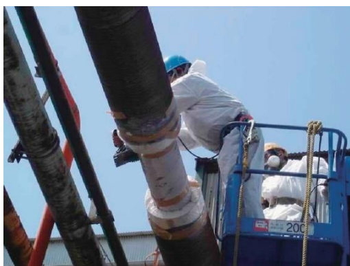
図 4.10.4 切断箇所の保温材除去と養生
