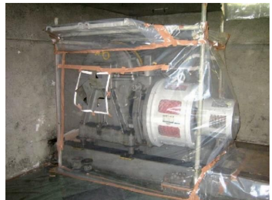
図 4.7.26 作業場内部の養生例 (エレベーター機械：接触防止用に布板敷き、発生熱を放散させる小窓を設置)
