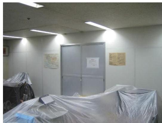
図 4.7.3 テナントビルの施工区画 (外部側、仮設扉)
