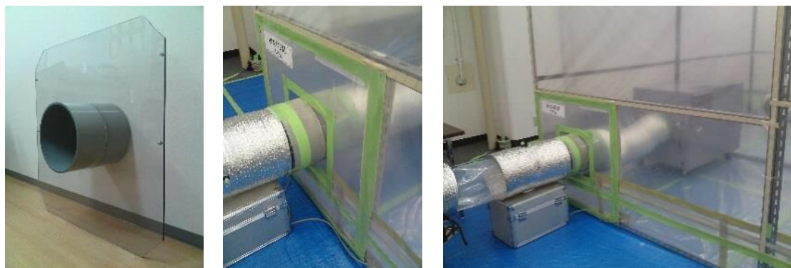
図4.14.14 排気ダクト貫通パネル例
