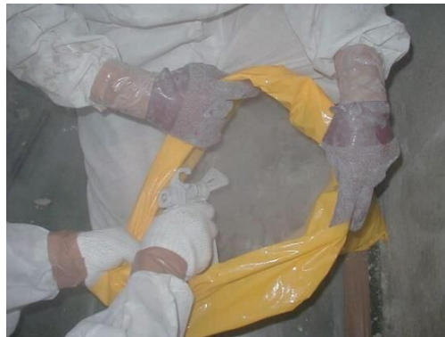
図 4.7.76 袋詰めした石綿廃棄物への粉じん飛散防止処理剤を散布
