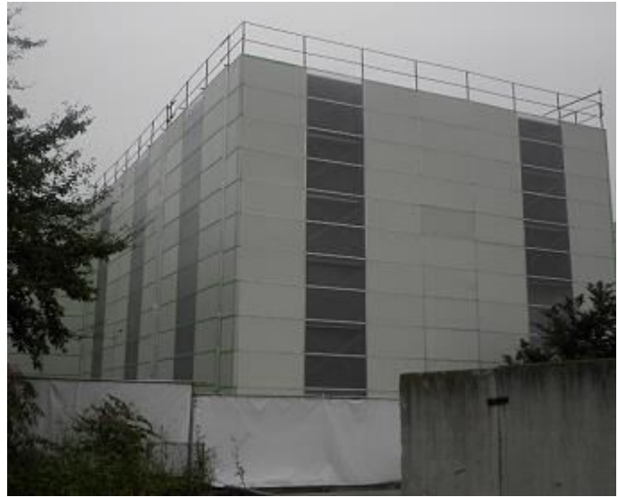
図 4.7.33 防音パネル／採光防音パネル施工例
