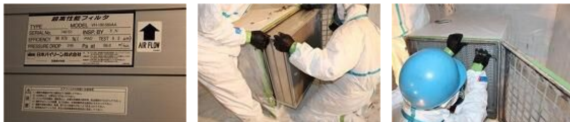
図 4.7.86 フィルタの取り付け
