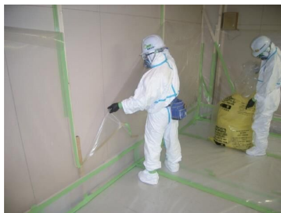
図 4.7.91 隔離シートの撤去
