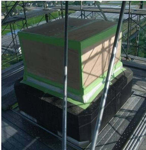
図 4.7.34 煙突開口部養生例
