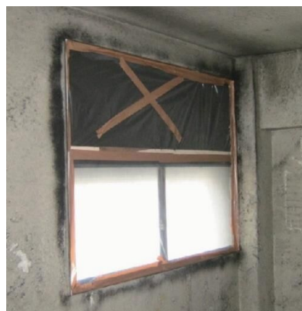
図 4.7.14 窓、換気口の負圧隔離養生例
