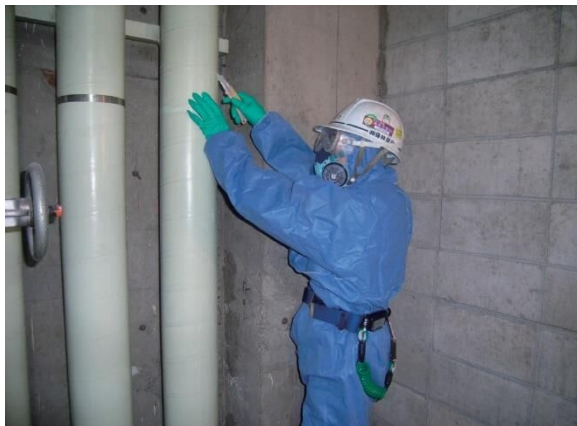
図 4.8.2 保温材被覆撤去
