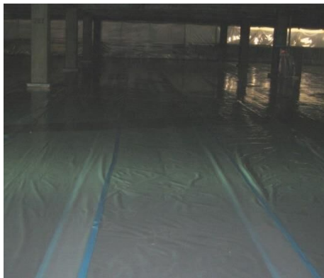
図 4.7.11 床面の負圧隔離養生例 (2重張り)
