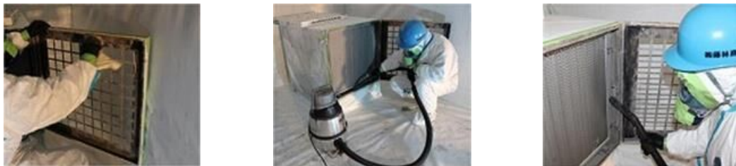
図 4.7.83 HEPAフィルタ等の清掃
