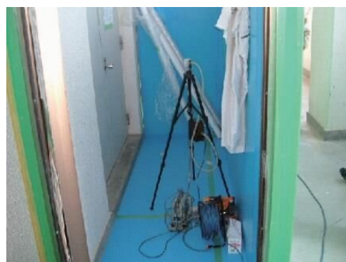
図 4.7.8 同左施工区画 (内部)
