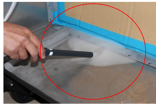
HEPA フィルタ取り付け面の隙間から煙が吸い込まれていく
