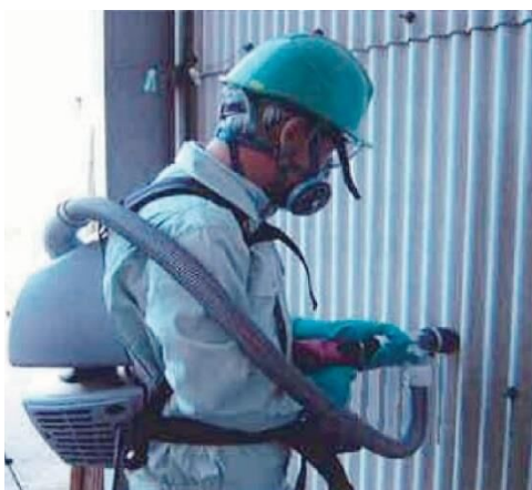
図4.11.7 機械工具による切断例
