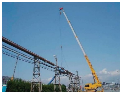
図 4.10.5 配管の吊り下ろし
