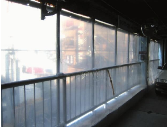
図 4.7.23 外壁の飛散防止措置例 (外部側にメッシュシート張り、内部側に隔離用 プラスチックシート等張り)
