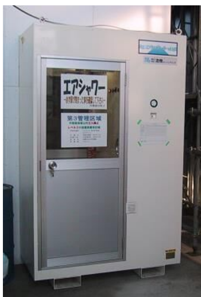
写真III-4 エアシャワールーム（2重扉）の例
