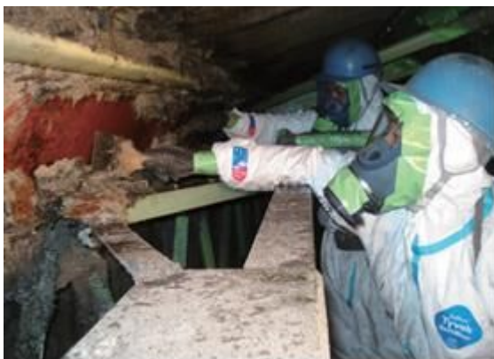
図 4.7.71 手工具（ヘラ）を使用した石綿含有吹付け材の除去作業（ブラッシング）
