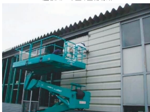
壁金物取外し
