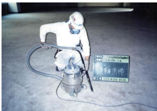
図4.11.21 清掃 高性能真空掃除機使用例
