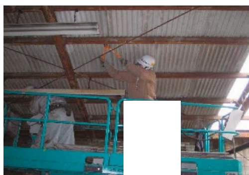
屋根スレート止め金物切断
