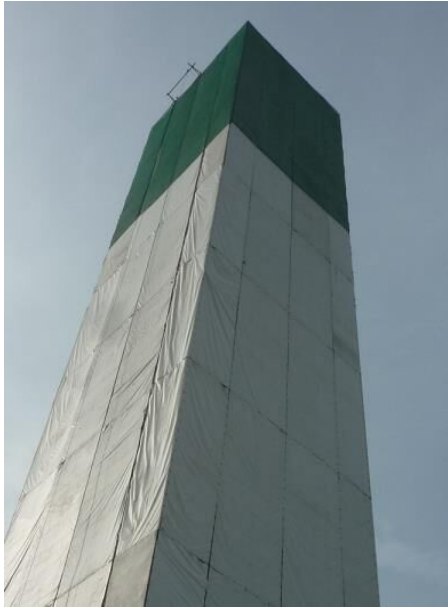
図 4.7.32 垂直ネットによる煙突頂部養生例
