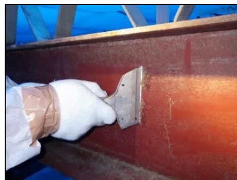
図4.15.5 再付着した石綿の除去
