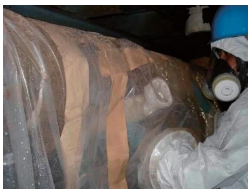
図 4.10.10 石綿除去作業中 2
