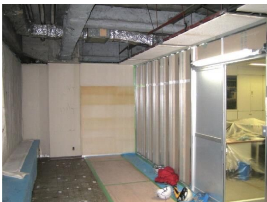
図 4.7.2 テナントビルの施工区画 (内部側)
