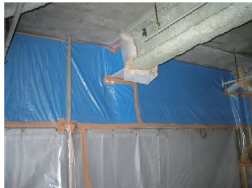
図 4.7.12 壁面の負圧隔離養生例 (作業場内側)
