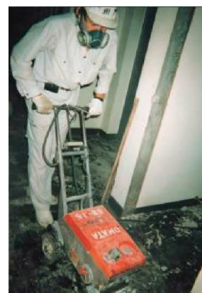
図4.11.12 石綿含有ビニル床タイルの 除去例
