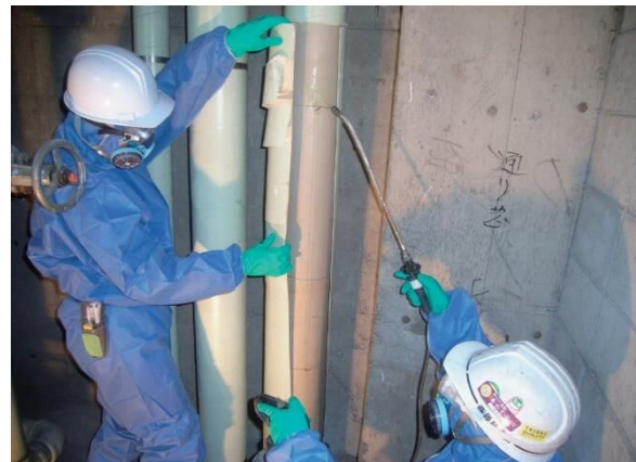
図 4.8.3 保温材の湿潤化→取り外し
