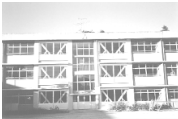
校舎耐震改修工事
