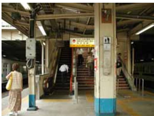
昇降設備(エスカレーター)(J R)
