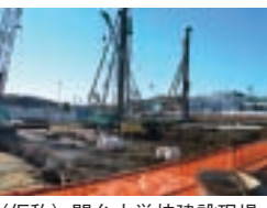
(仮称)関台小学校建設現場
