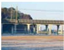
千駄堀最終処分場跡地(千駄堀スポーツ広場)
