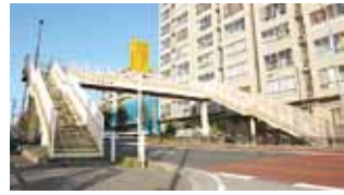
国道6号にかかる馬橋弁天歩道橋
