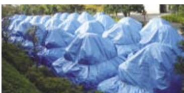
クリーンセンターの飛灰保管場所
