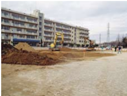
除染作業を全力で進めています
