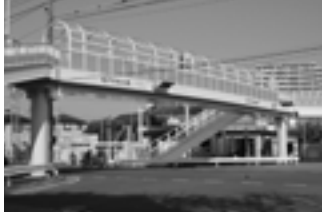
塗装改修された子和清水歩道橋
