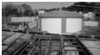
建設中の小金浄水場
