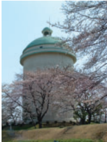
千葉県水道局栗山浄水場配水塔(地図は8面に掲載)
