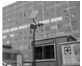
市役所前の太陽光発電街路灯
